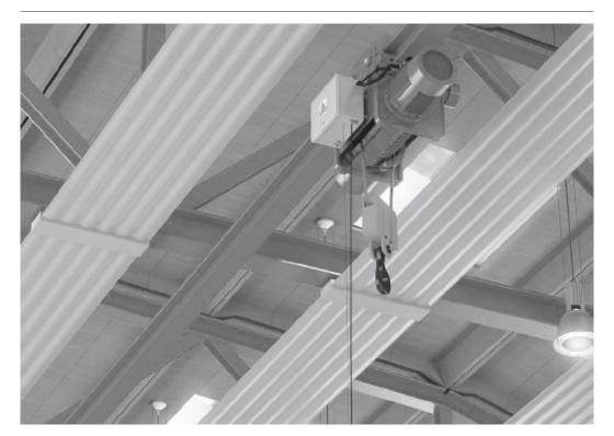
Водяные потолочные излучающие панели Velum подходят для отопления/охлаждения промышленных, торговых, спортивных помещений и являются идеальным решением для производственных и монтажных цехов, цехов по изготовлению деревянных модельных комплектов, химических и пищевых производств, складов, логистических комплексов, вместительных гаражей, ангаров, автосервисных центров, спортивных залов и стадионов, супермаркетов и т.п.
